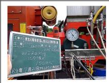
工種: コンクリート表面処理工 内容: 施工日の噴射圧力確認 規格値: 基準試験結果の150Mpa
