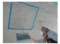
工種: コンクリート表面処理工 内容: 基準試験(圧力選定) 決定値: ディスクサンダー処理を良好と判定
