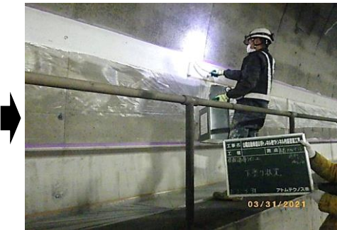
④ 下塗り工
