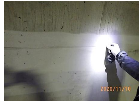
③ 墨出し工
