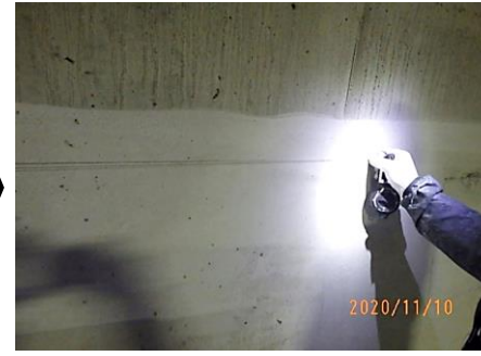
③ 墨出し工
