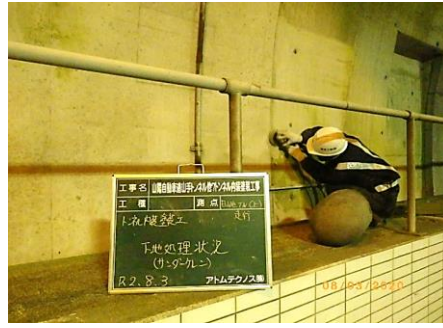
② 下地処理工
