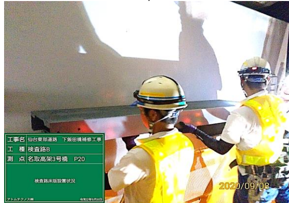
⑤ 床設置状況
