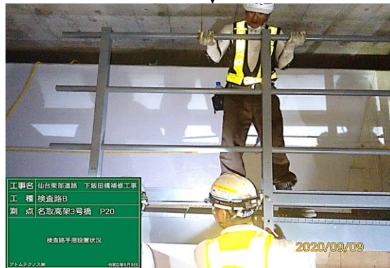
⑥ 手摺設置状況
