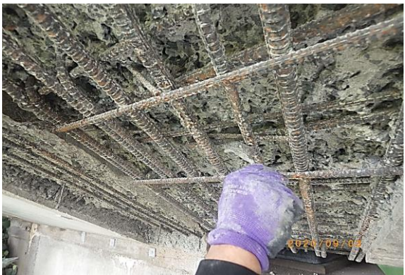
④ 鉄筋ケレン状況
