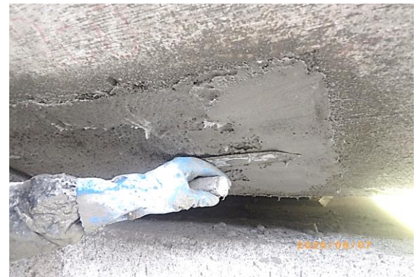
⑥ コテ仕上げ状況
