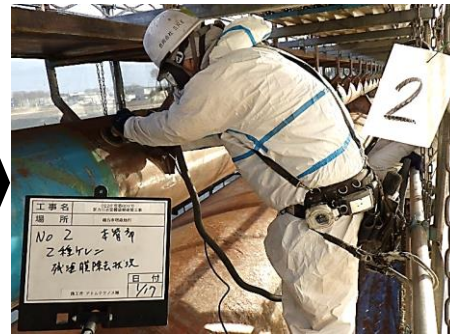
③残塗膜除去工
