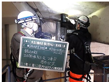
⑤錆止め塗料2層目塗布
