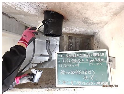
④錆止め塗料1層目塗布
