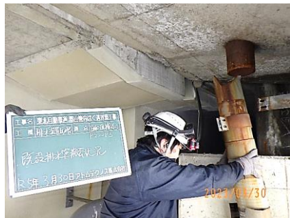
②既設排水管撤去
