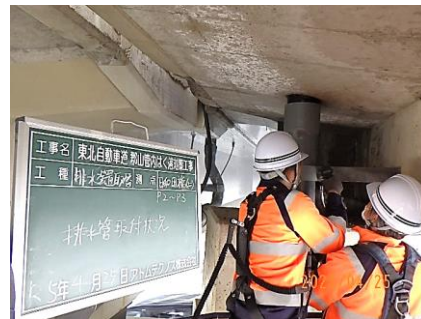
⑥排水管取付け
