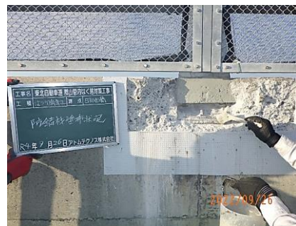
⑤ 防錆材塗布
