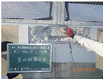
④ 鋼材素地調整
