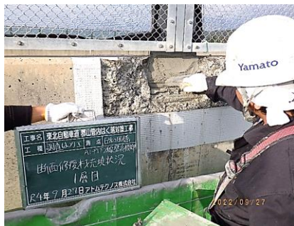
⑦ 断面修復材充填
