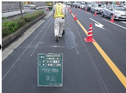
④プライマー散布状況
