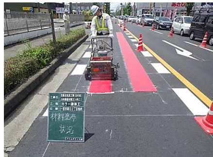
⑤塗布状況 (施工)
