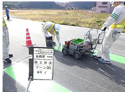
⑤塗布状況 (施工)
