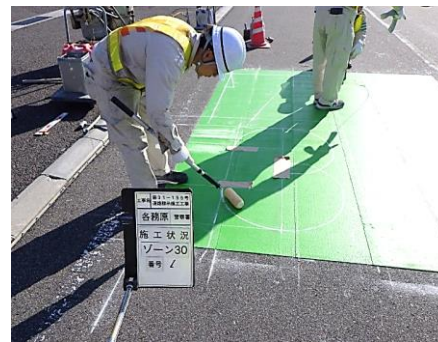
④プライマー散布状況
