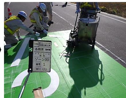
⑤塗布状況 (施工)
