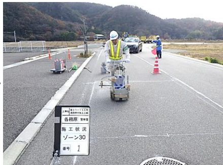
④プライマー散布状況
