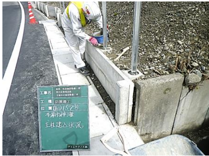
④支柱建込状況
