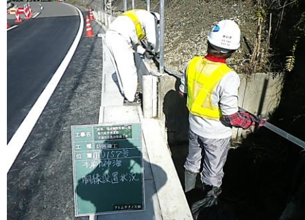
⑤胴縁設置状況
