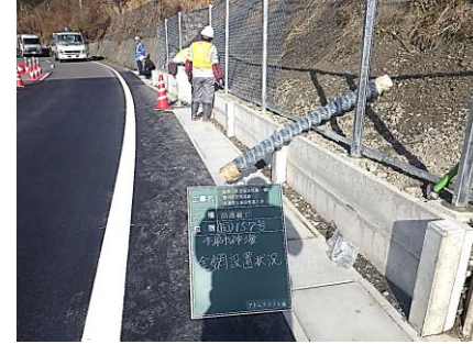
⑥金網設置状況
