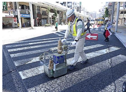
④プライマー散布状況
