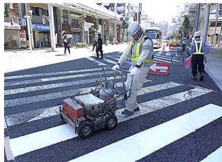
⑤塗布状況（施工）
