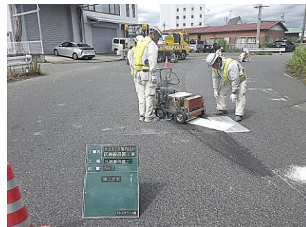
⑤塗布状況 (施工)
