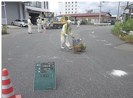
④プライマー散布状況
